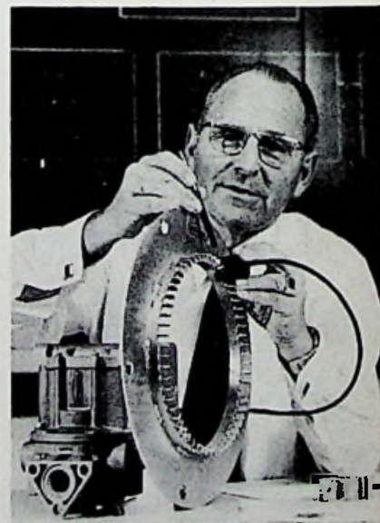
Afb. 1. De getande rotorschijf met magnetische voeler om de wielsnelheid te meten en de computer met relaisventiel om de remdruk te regelen.
